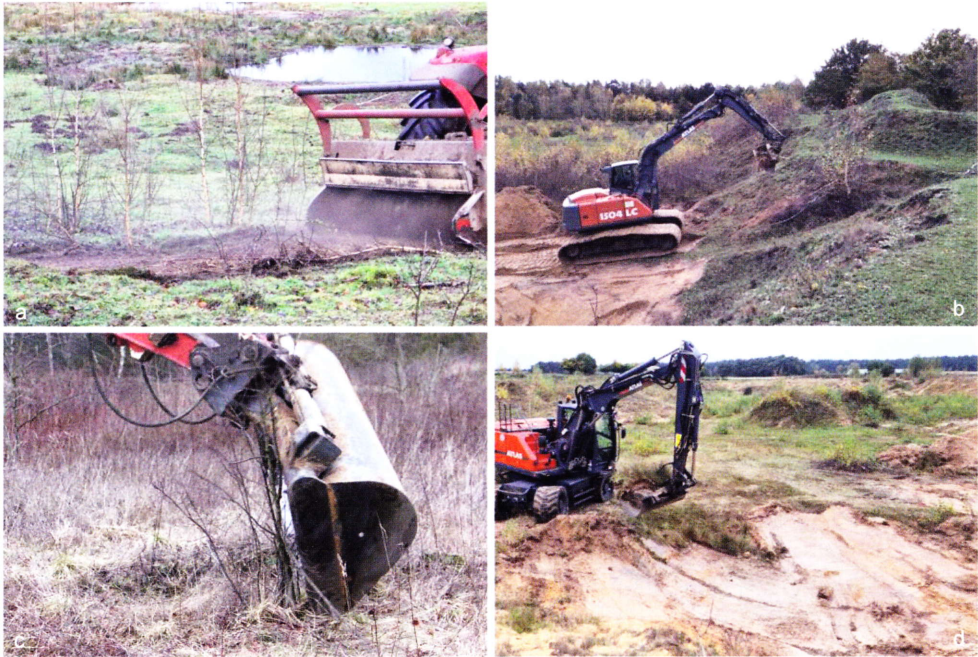
Abb. 9: Kleinere und dicht aufwachsende Bäume und Sträucher werden mit einem Forstmulcher entfernt (a). Unerwünschte, größerer Gehölze entnimmt ein Bagger mit einer Baggerschaufel, mit der er auch die in der Sandkuhle kleinen aber unwegsamen Hänge und Abbruchkanten erreichen kann (b, c). Die Kleingewässer werden im mehrjährigen Abstand in einen Rohbodenzustand versetzt, um vor allem Kreuzkröten zu fördern (d). Fotos: E. Lüers.
